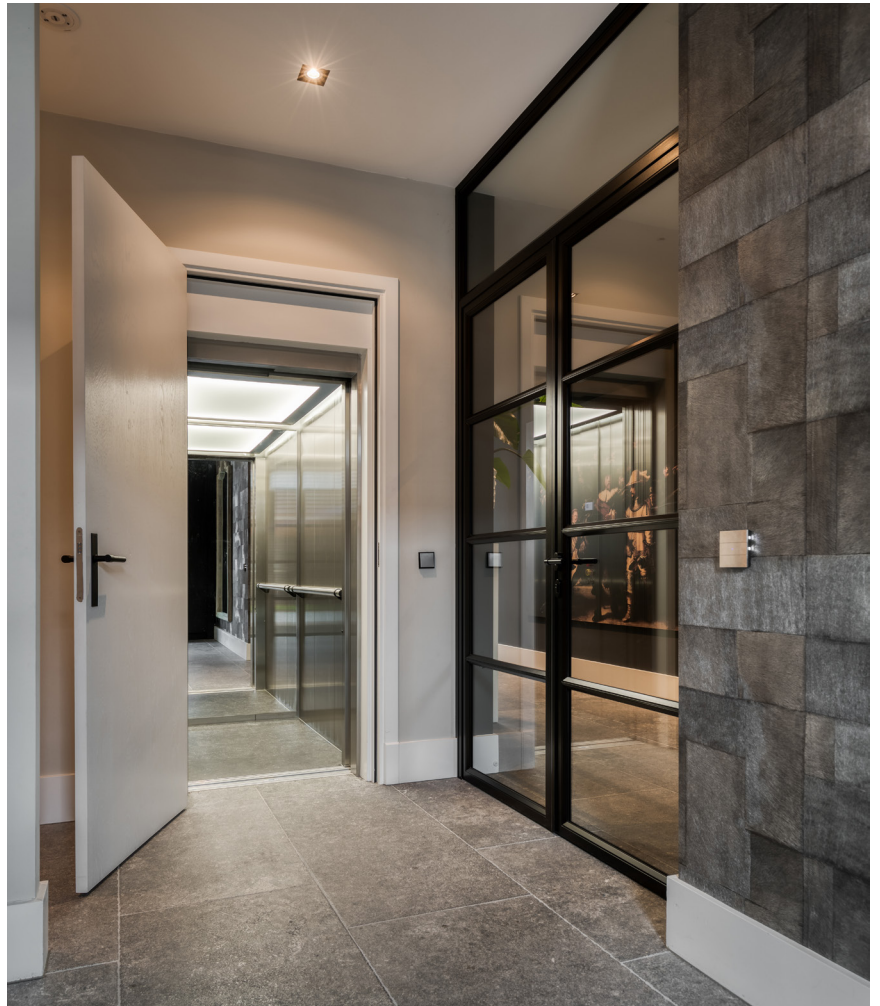
thyssenkrupp Home Solutions is verantwoordelijk voor de levering en plaatsing van de personenlift.
